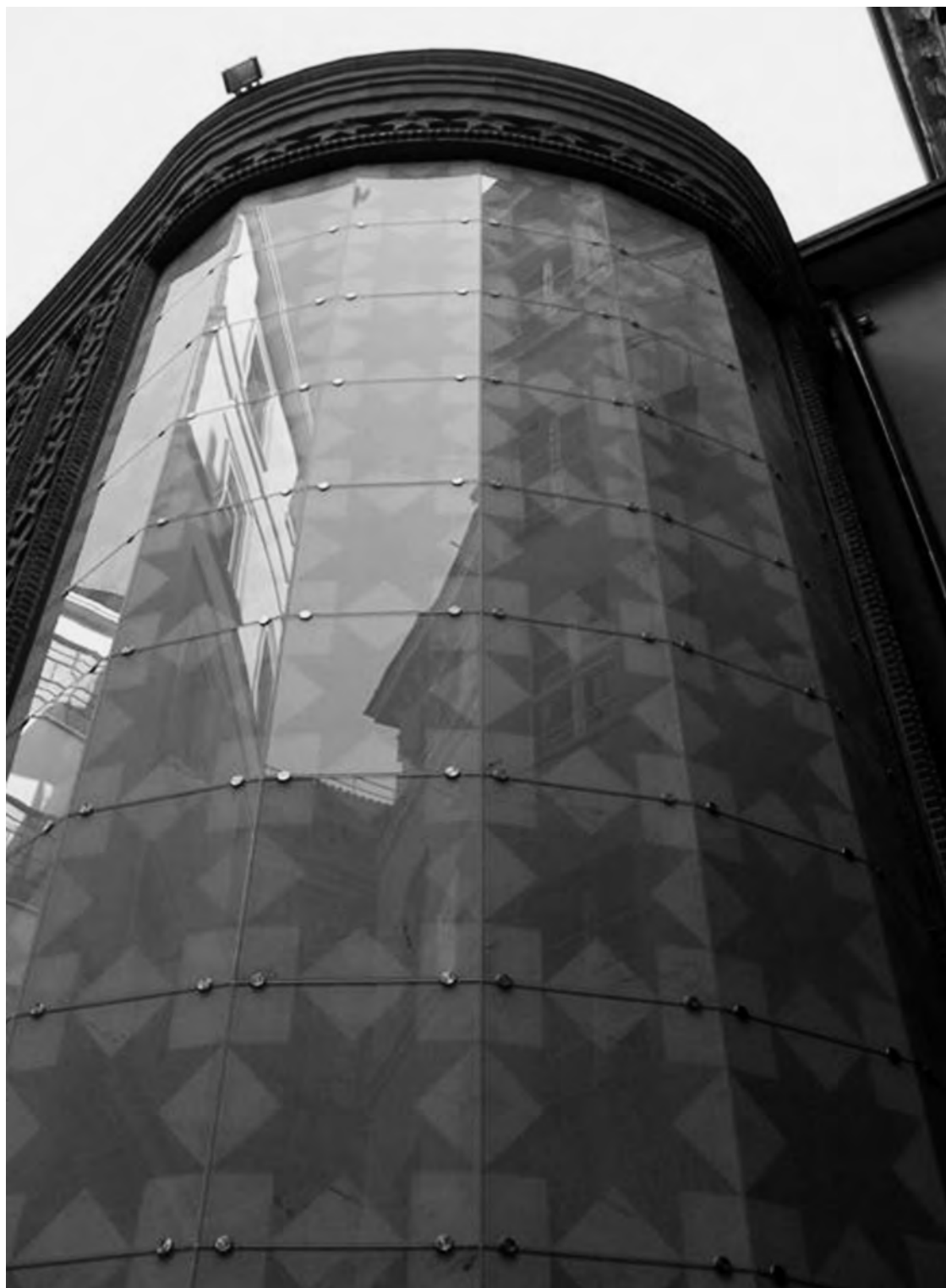
92. Torino, Teatro Carignano, la scala di sicurezza di sinistra a lavori conclusi. Le vetrate sono in alabastro e cristallo, e rievocano il motivo a stella ottagonale di rueda de ocho andalusa, apprezzato dal Guarini nel suo viaggio in Spagna per poi andare in Inghilterra, in Francia e in Boemia prima di fermarsi a Torino.
