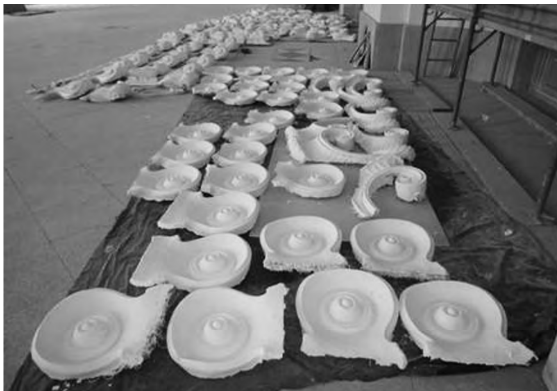
68. Torino, Venaria Reale, a terra i calchi in vetro-resina del lato settentrionale pronti all'esecuzione dei rilievi in stucco di calce e polvere di marmo.
