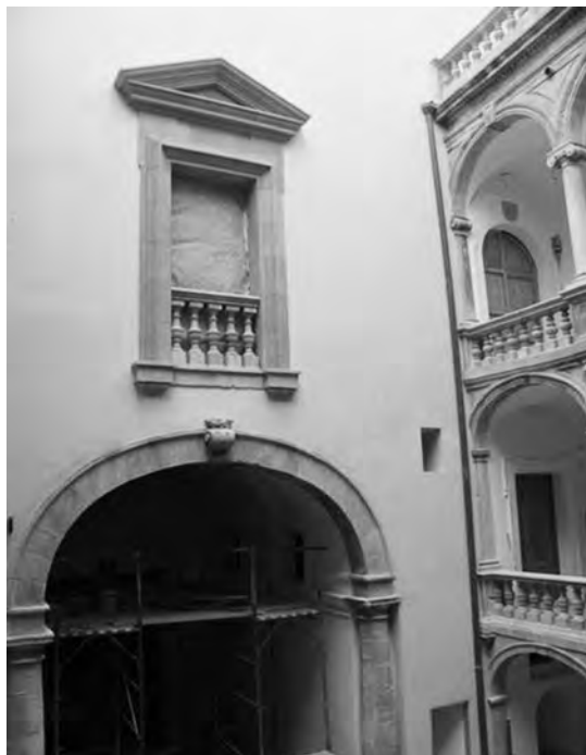
30. Trapani, Palazzo Riccio di San Gioacchino: finestra ripristinata alla maniera delle preesistenti.
