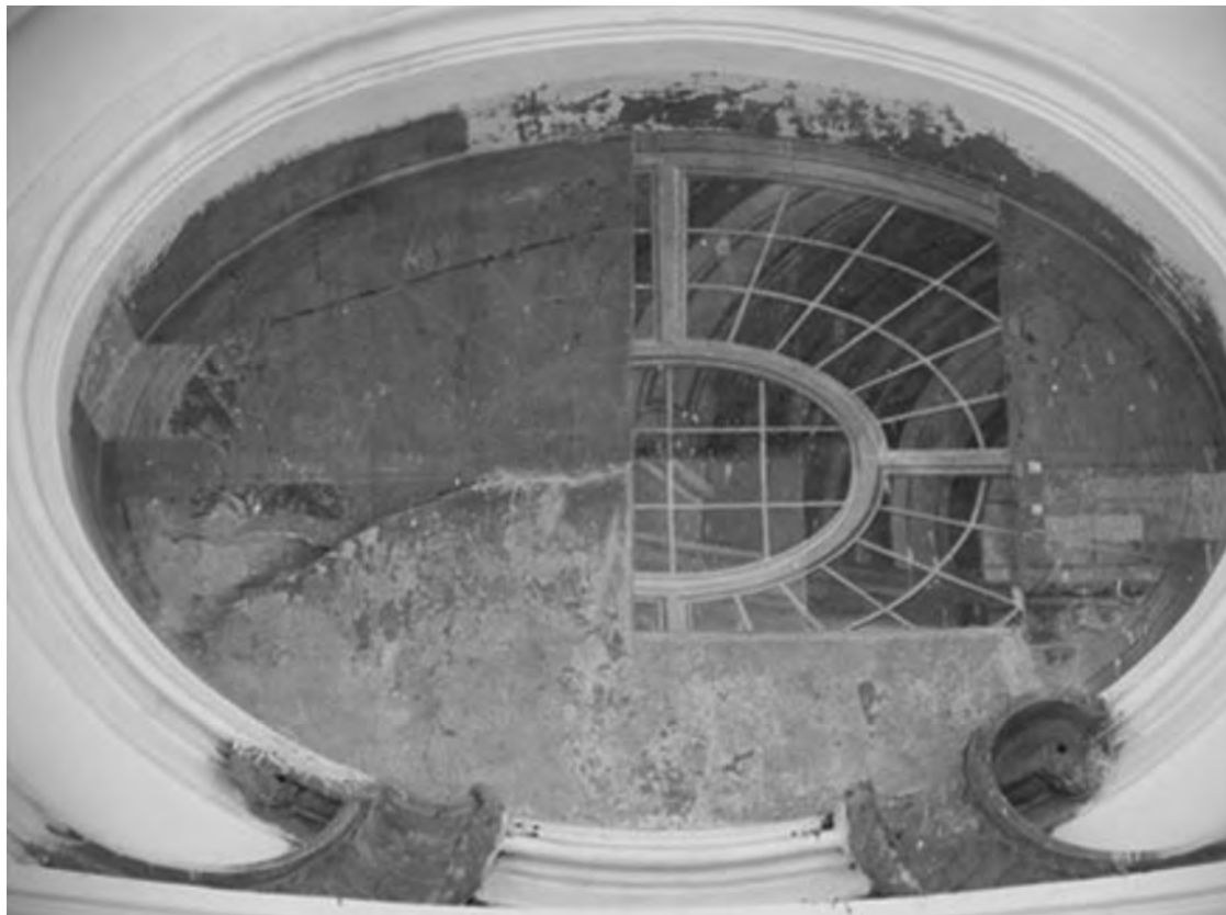
65. Torino, Venaria Reale, uno dei trompe l'oeil a fresco sopra una delle false-porte della Citroniera a contatto con le Scuderie. Essi sono stati restaurati "all'antica", ripristinando i dipinti che rappresentano sfondi architettonici e "appannando" i vetri sottostanti, nei quali le efflorescenze saline derivanti dall'uso di stalla avevano del tutto cancellato il tema pittorico.
