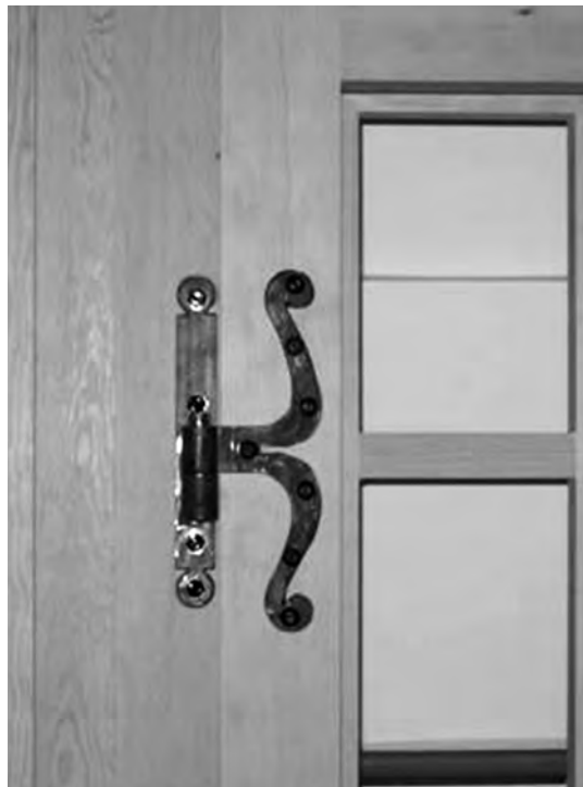
70. Torino, Venaria Reale, ferramenta come e dov'erano; i vetri a doppia camera.
