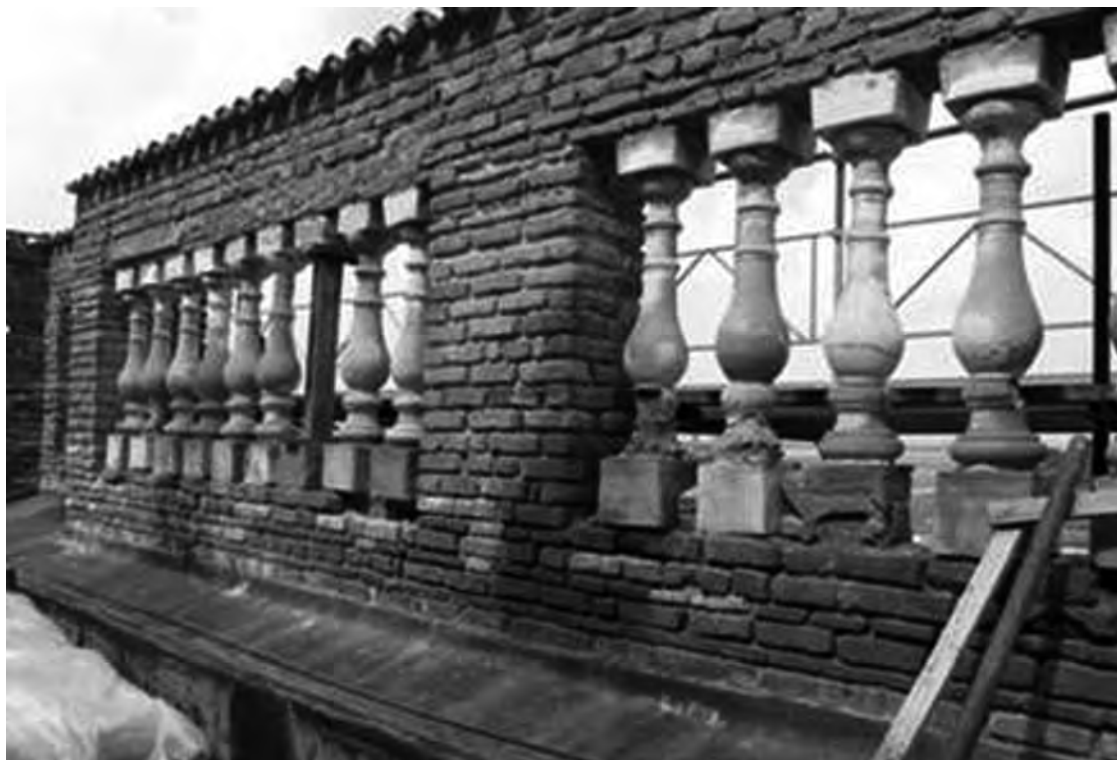
63. Torino, Venaria Reale: ripristino dei balaustri e costruzione di un passaggio coperto "all'antica" sul terrazzo.
