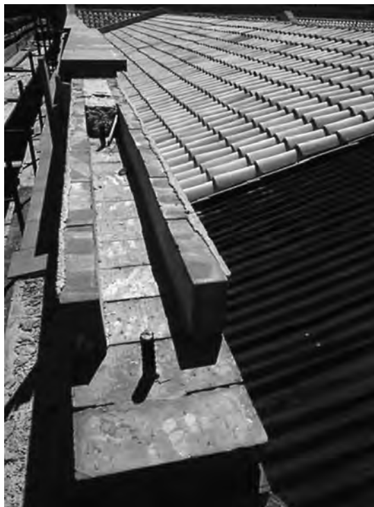
28. Trapani, Palazzo Riccio di San Gioacchino: il cordolo in cemento armato con un solo ferro centrale "alla maniera" di Antonino Giuffrè.
