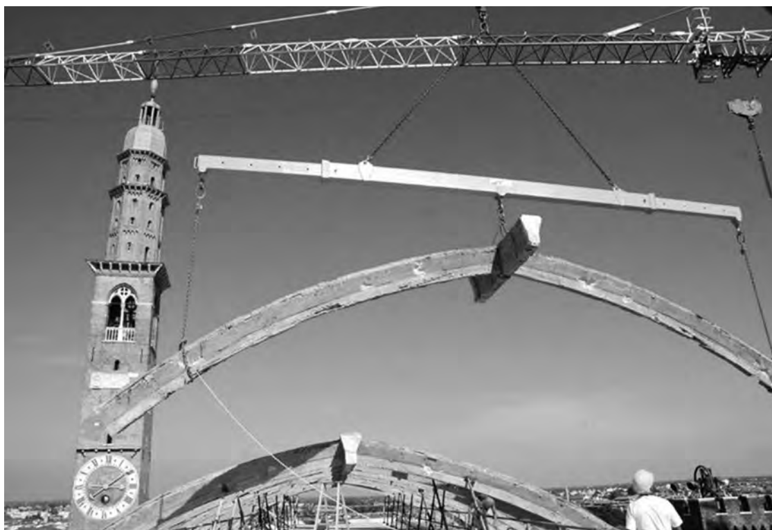
46. Vicenza, Basilica Palladiana: una delle fasi di smontaggio della volta.
