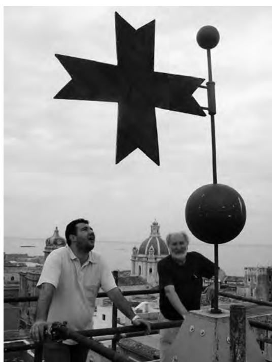
33. Trapani, Palazzo Riccio di San Gioacchino: particolare dell'asta segnamento connessa alla cuspide in legno.
