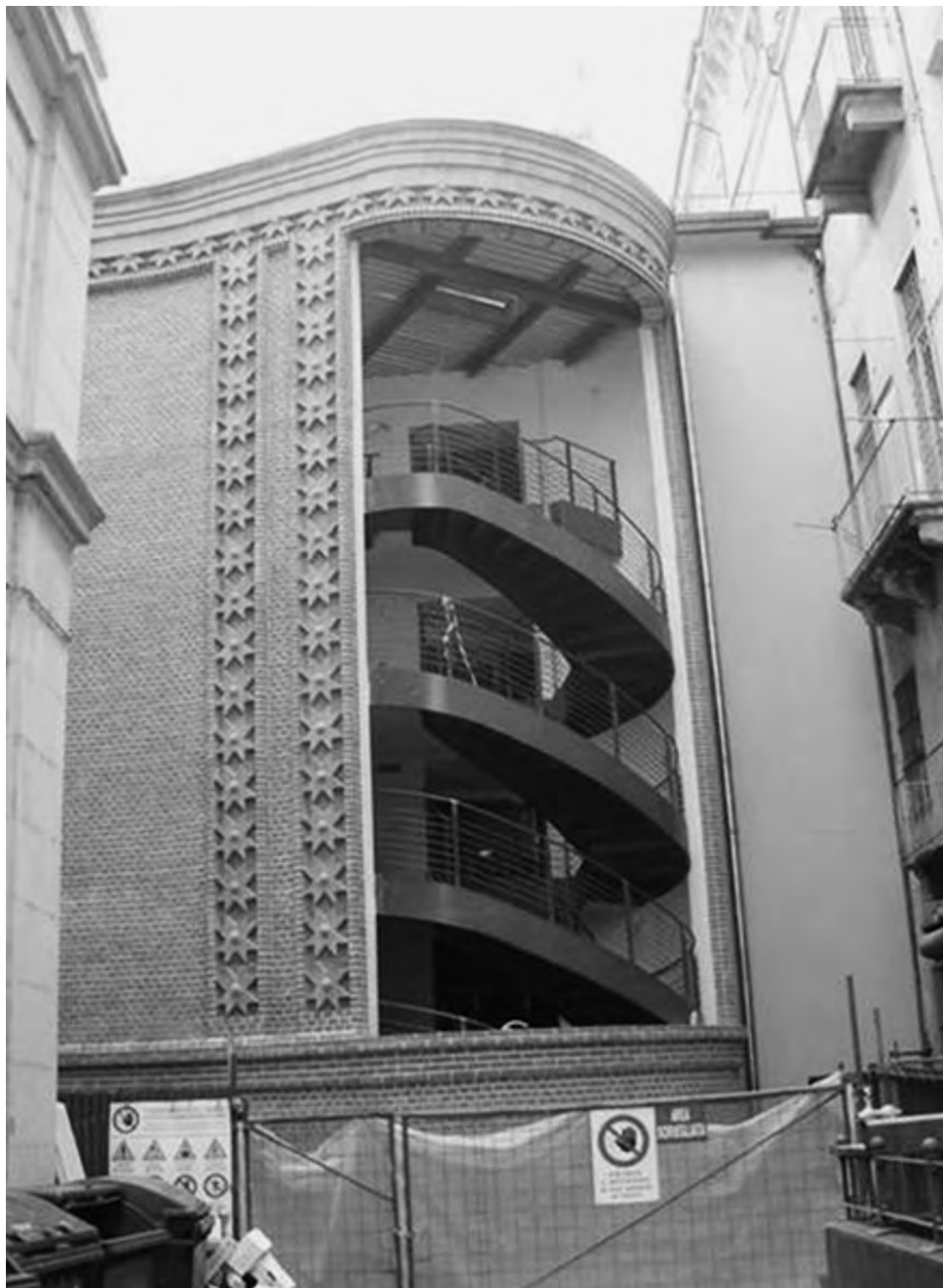
87. Torino, Teatro Carignano, la scala di sicurezza di sinistra durante i lavori: si distingue la struttura in acciaio delle rampe e della copertura.
