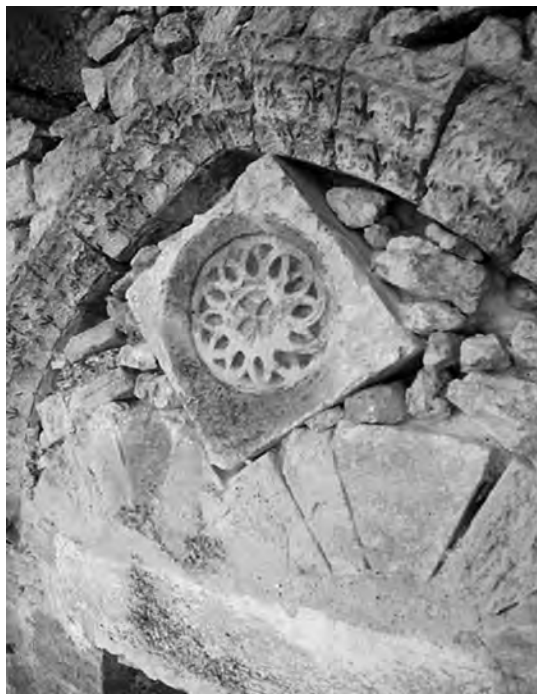
9. Alcamo (TP), Castello dei conti di Modica. I lavori ottocenteschi di trasformazione del Castello in carcere non furono sofisticati, come si vede dal rabbercio realizzato per concludere una bifora, da noi ripristinata.
