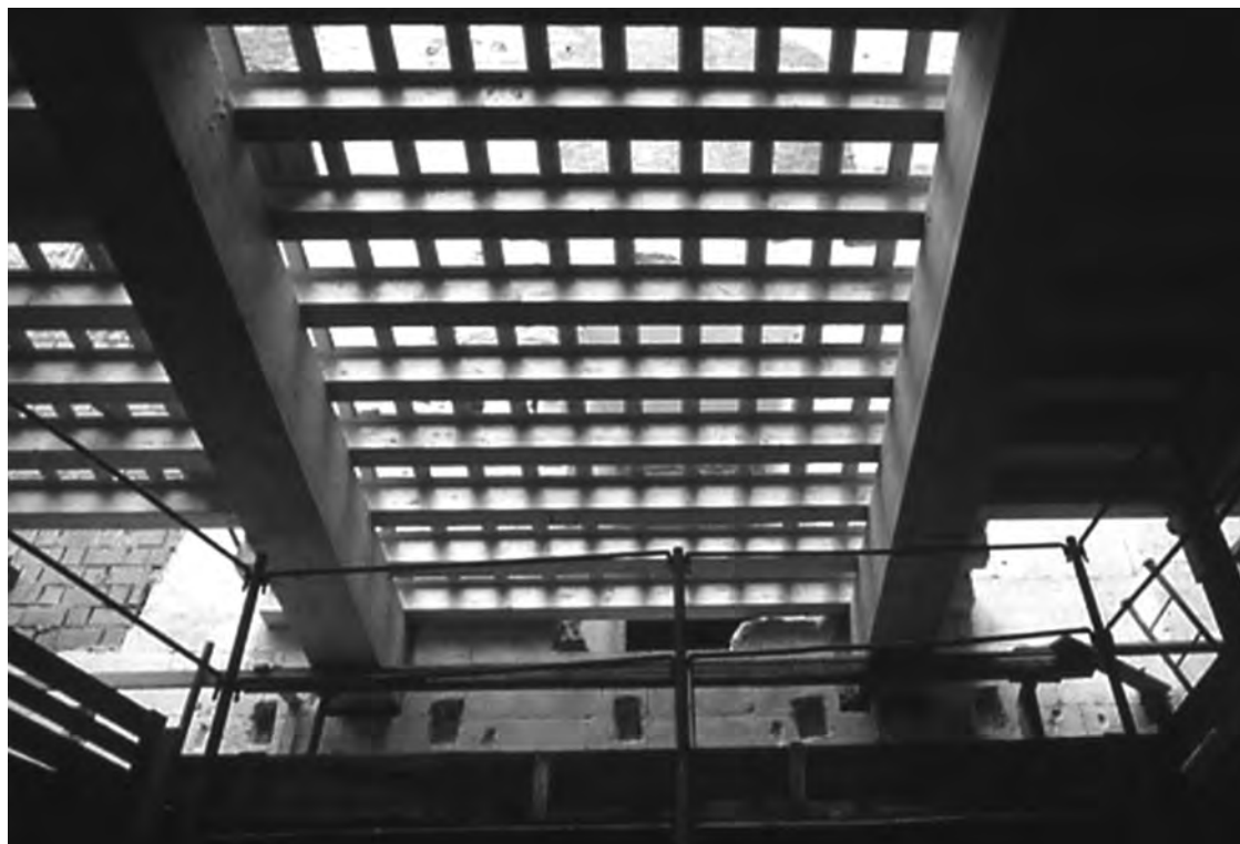
55. Brescia, Il Broletto: solaio in legno lamellare di "tipo" romano seicentesco nell'ala del Cardinal Querini.
