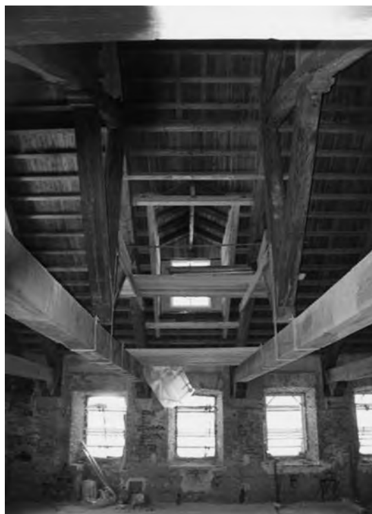
62. Torino, Venaria Reale: la ricostruzione degli abbaini alla maniera francese, documentati nelle foto anteriori alla loro demolizione, ha consentito un magnifico riutilizzo del sottotetto ad uso di sale espositive e ristorante con cucine e servizi.
