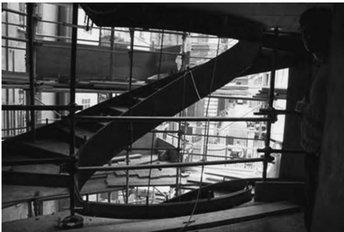
88-89. Torino, Teatro Carignano, la scala di sicurezza di sinistra durante i lavori: vista dall'alto e vista di fianco.
