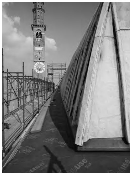
49. Vicenza, Basilica Palladiana: rimontaggio della copertura in rame ottocentesca.
