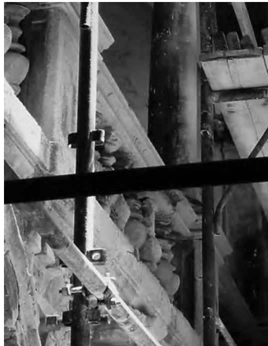
21. Trapani, Palazzo Riccio di San Gioacchino: balaustri degradati sostituiti con elementi di identico materiale e fattura.
