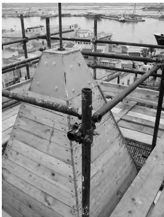
32. Trapani, Palazzo Riccio di San Gioacchino: la nuova cuspide della torre realizzata in legno per una maggiore leggerezza e flessibilità in caso di terremoto.
