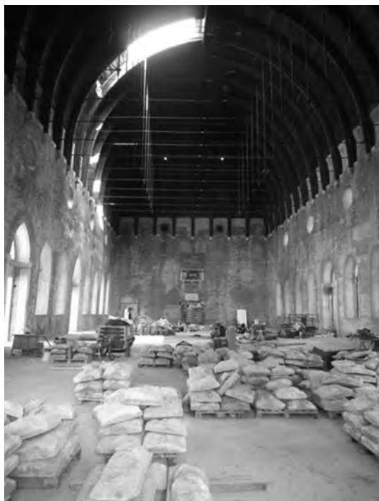
48. Vicenza, Basilica Palladiana: la volta ricostruita in legno lamellare applicandole il rivestimento ligneo degli anni '50.
