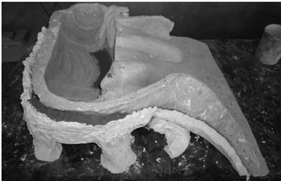
67. Torino, Venaria Reale, rifacimento degli stucchi con la stessa tecnica descritta dal Vasari per costruirli: calchi in vetro-resina (Vasari ricorreva al gesso) per la produzione dei rilievi; qui un calco.
