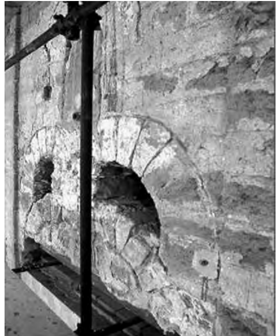
3. Palermo, La Zisa. Una bifora normanna sotto l'intonaco.
