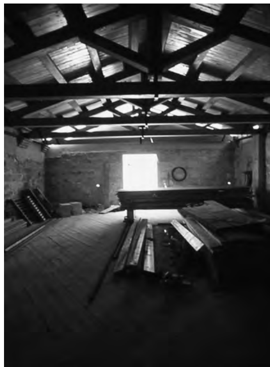
29. Trapani, Palazzo Riccio di San Gioacchino: il tetto in legno lamellare.
