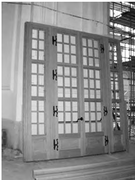
69. Torino, Venaria Reale, gli infissi della Citroniera in legno lamellare.
