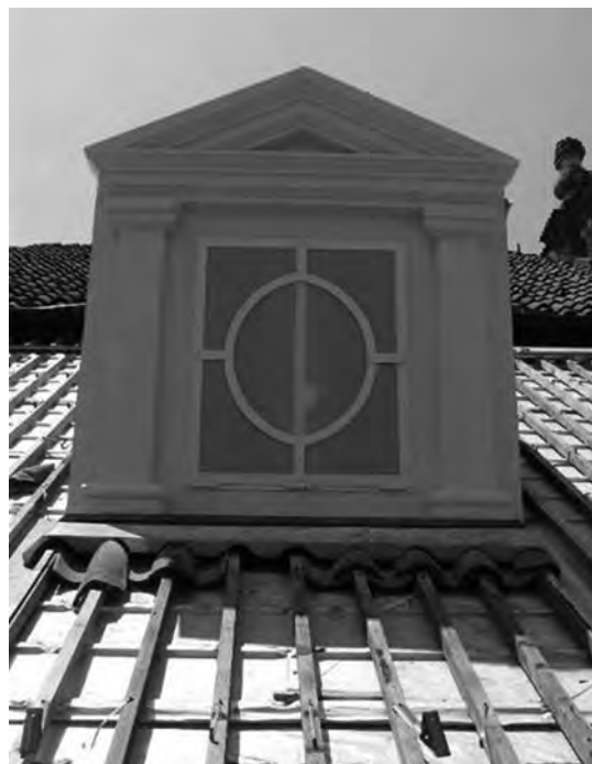
61. Torino, Venaria Reale, i nuovi abbaini lignei, al posto di quelli demoliti nei restauri degli anni '80. Veduta esterna.
