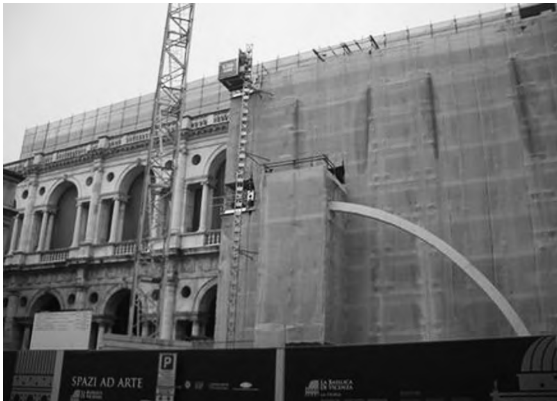
47. Vicenza, Basilica Palladiana: un arcone in legno lamellare (Holzbau di Bressanone) sta per essere montato al posto di un arcone in c.a.
