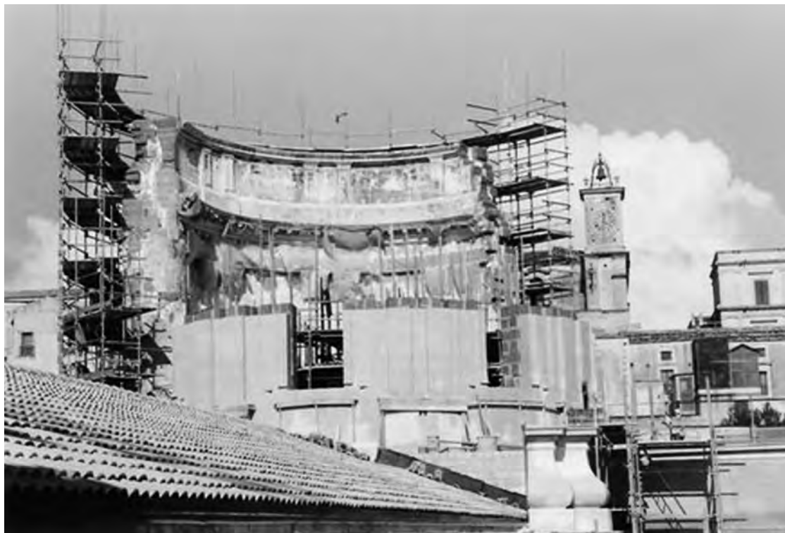
37. Noto, la Cattedrale: particolare delle ricostruzione della cupola con pietra locale.
