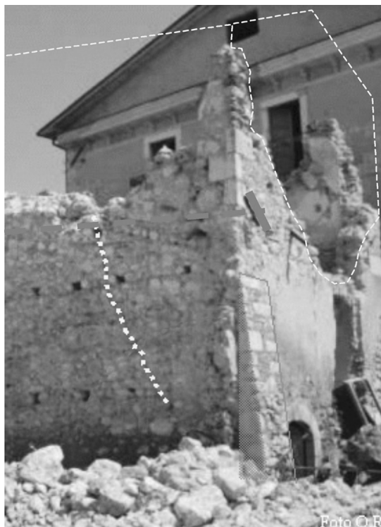
1. La chiesa diroccata di Castelnuovo di San Pio delle Camere (AQ). Si conserva il cantonale lesionato per effetto del contrasto offerto dalla sperone di facciata e dalla catena sovrastante.
