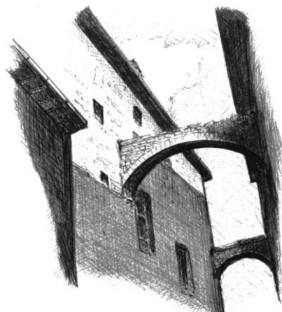
19. Citerna (PG), gli archi di sbadacchio che attraversano i vicoli e collegano edifici contrapposti, danno continuità alla successione di arcate presenti all'interno di ogni cellula.
