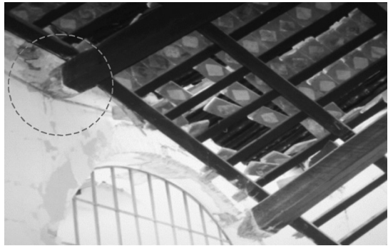
10. Ipotesi di sfilamento delle travi maestre di un solaio ligneo, aggravata da testate di travi ammalorate, a confronto con una situazione reale riscontrata nel centro storico de L'Aquila.
