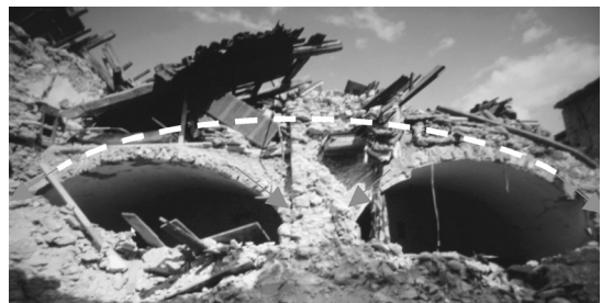
17. Contrasto di elementi spingenti orditi in senso ortogonale alla facciata in un edificio distrutto dal terremoto in Abruzzo.
