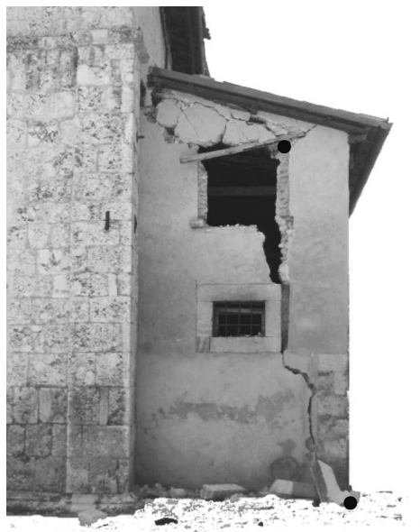
21. Cinematismo strutturale di un edificio del centro storico de L'Aquila colpito dal sisma del 6 aprile 2009.
