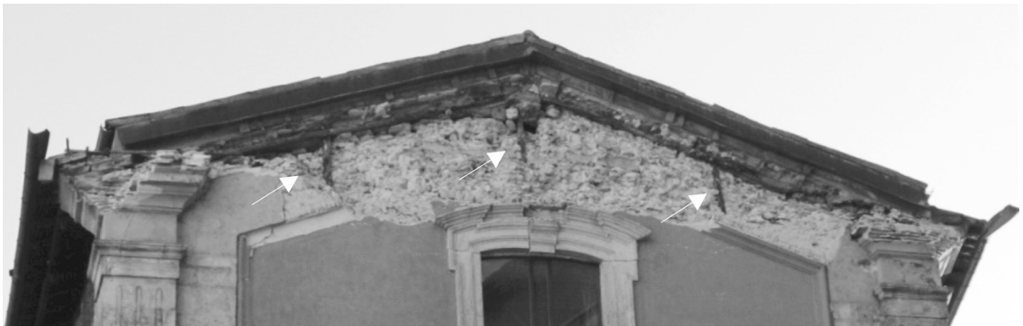
15. Esempio di intelaiatura lignea con "cordolo" di coronamento connesso ad elementi verticali occultati nella muratura di pietrame.
