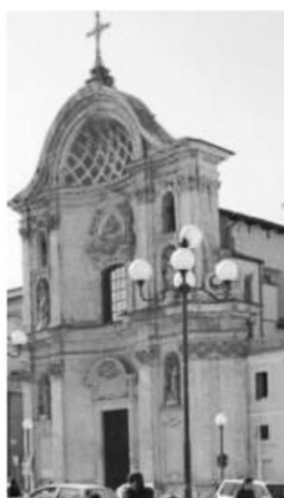
3. Volta ad asse verticale su parete vincolata ai lati, concretizzata nella facciata della chiesa delle Anime Sante nel centro storico de L'Aquila.
