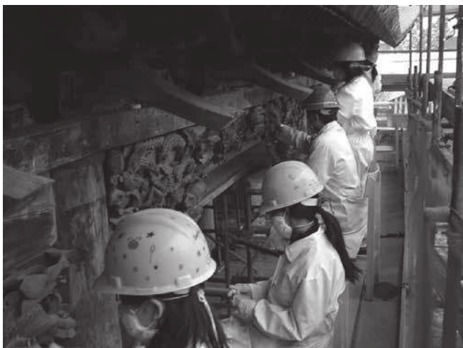
6. Interventi sulle superfici policrome dell'architettura nella Gilda ShanShaan di Luoyang, provincia dello Henan in occasione del cantiere didattico del 2004.
