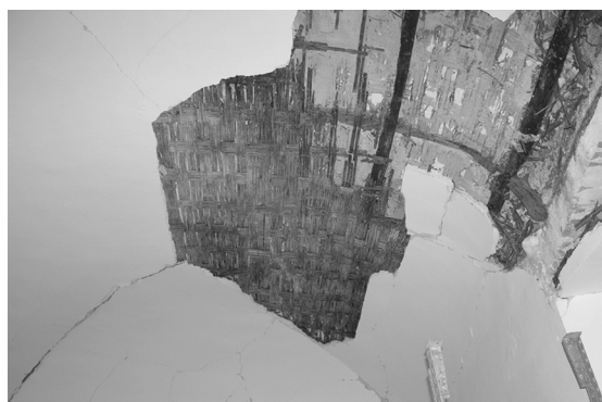
16. L'Aquila: volta di mattoni in foglio in un edificio di Via Garibaldi, probabilmente danneggiata dalla caduta di elementi del tetto.
