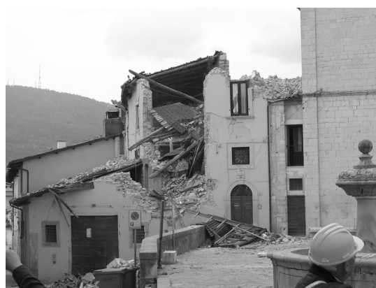
10. L'Aquila, edificio a fianco della chiesa di S. Marciano prima del sisma del 6 aprile e, a destra, la stessa struttura dopo il crollo dell'angolata.
