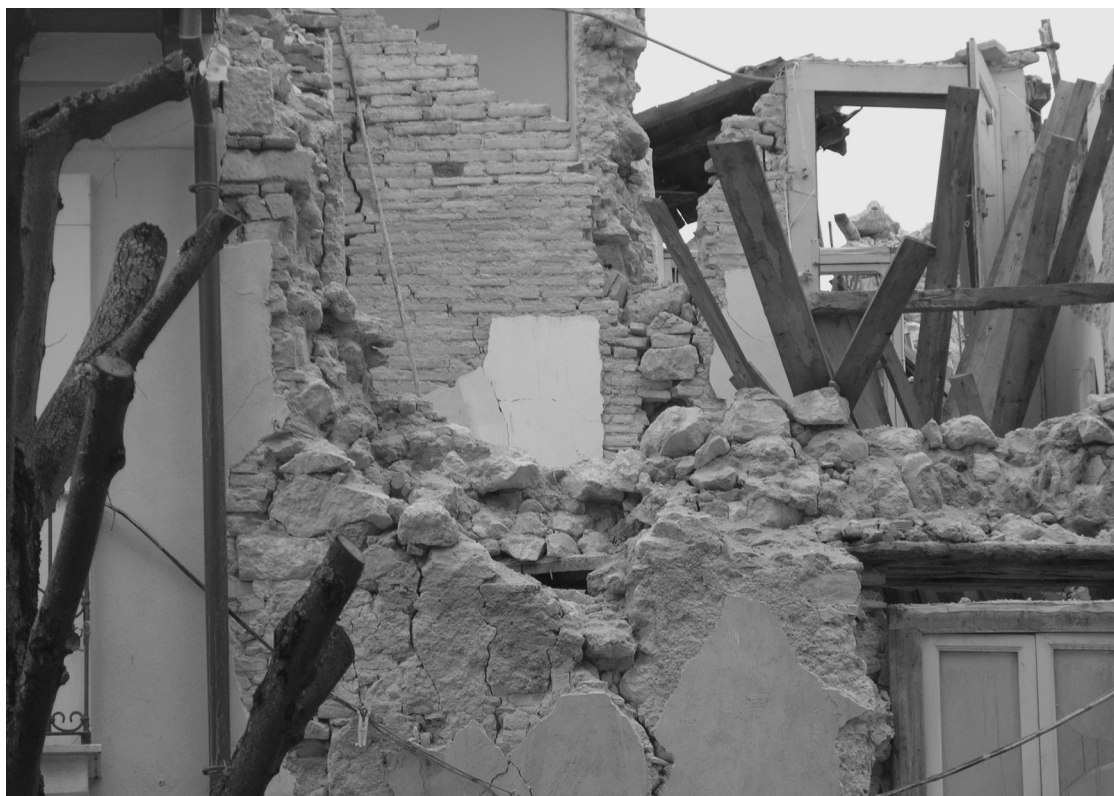
14. L'Aquila, esempi di murature di scarsa qualità.
