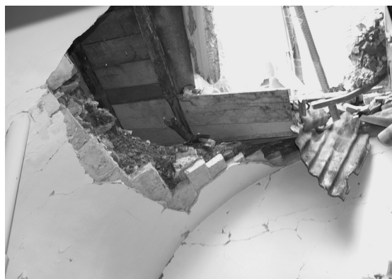
15. Meccanismo di collasso di un arco trionfale per forze di massa orizzontali.
