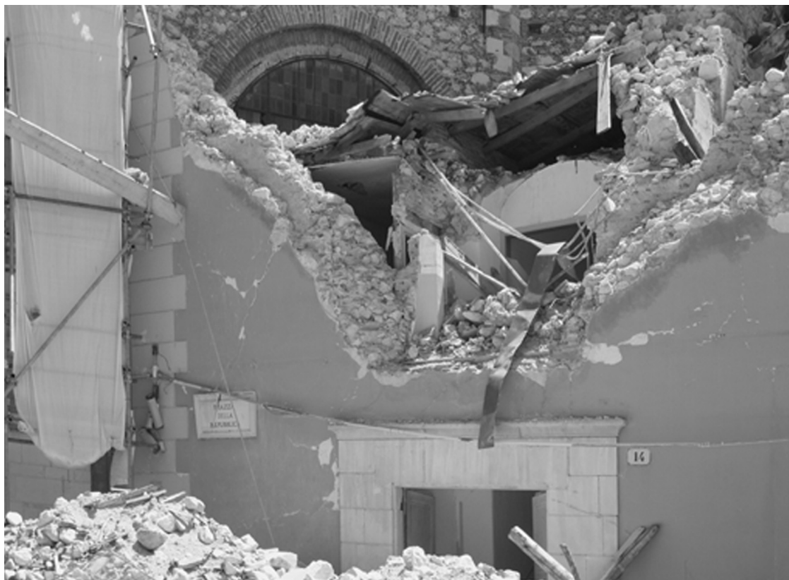
1. Gli esiti delle trasformazioni della compagine materiale degli edifici. L'Aquila, Piazza della Repubblica: l'edificio del Governo crollato per il sisma del 6 Aprile 2009 mostra di essere il prodotto della ricomposizione di edifici precedenti riformati attraverso rimpelli e rabberciamenti di parti preesistenti. Il nuovo assetto non ha potuto esprimere un comportamento efficace in occasione del sisma.
