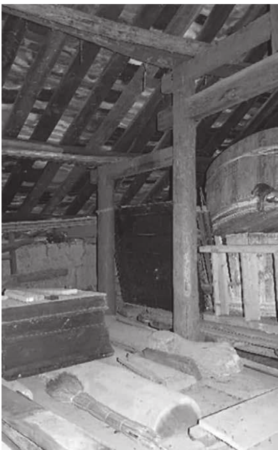
6. La struttura in legno del Jiquin Lou è una combinazione delle due principali tipologie costruttive: a "montante e architrave" ( post and lintel ) e a "colonne e travi" ( column and tie ). Dal 2006 Jiqing Lou è stato inserito nella lista dei monumenti protetti a livello nazionale.
