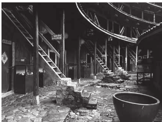
5. Il Jiqing Lou, costruito tra il 1403 e il 1424, è un edificio a 4 piani a doppio anello, con 56 stanze a piano, distribuite da scale individuali per ogni abitazione.
