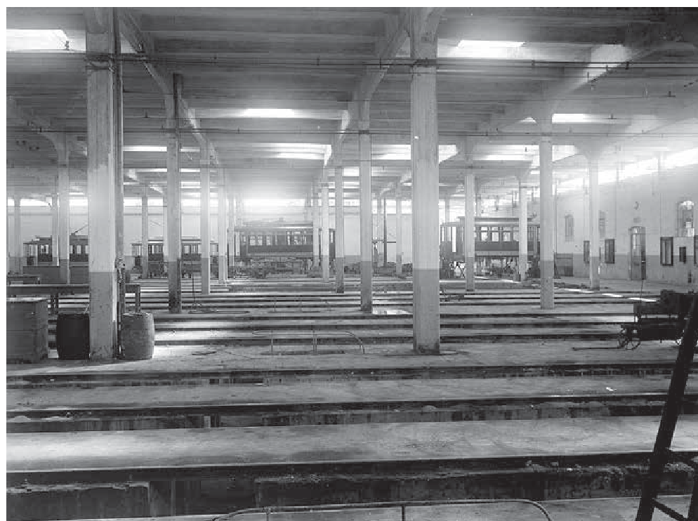
5. Il Deposito "Vittoria", fosse d'ispezione all'interno del deposito, 1930 (Roma, Archivio Fotografico Atac).
