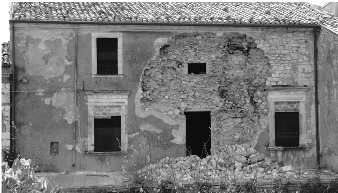
6. S. Valentino in Abruzzo Citeriore (Pescara), lesioni provocate dal sisma dell'aprile 2009: notare la scarsa tenuta delle malte e la presenza di un camino richiuso nel muro (foto S. Cecamore).
