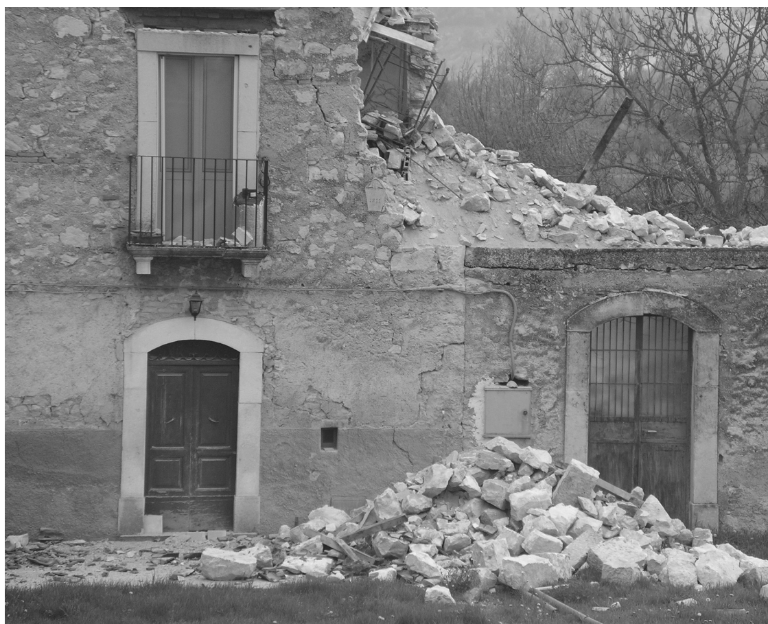
5. Casa nei pressi di Bazzano (AQ): è evidente il ruolo della malta e della manutenzione nella resistenza delle murature.
