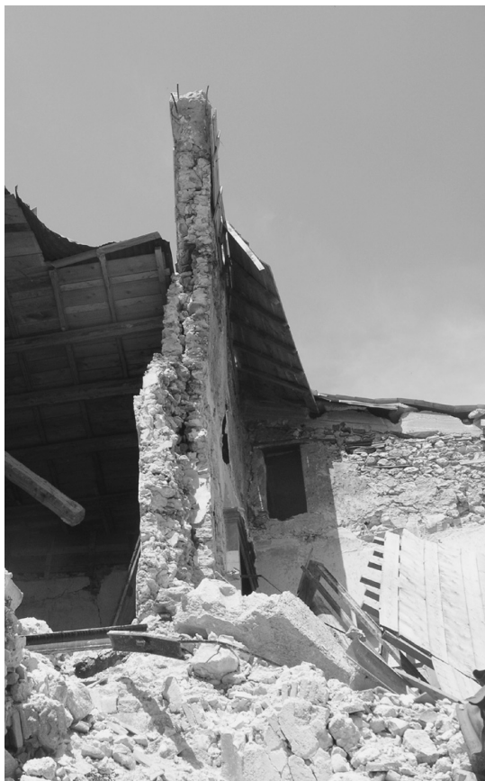
16. Castelvecchio Subequo, crollo delle murature tradizionali in bozze scarsamente ingranate e con malta aerea.
