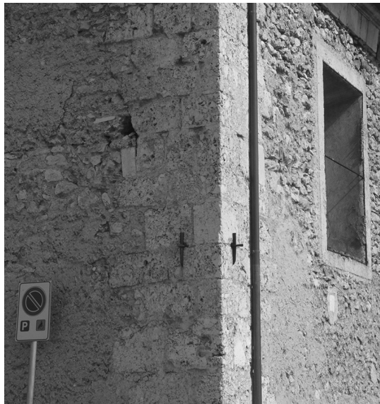
4. L'Aquila, S. Maria del Soccorso, capochiavi metallici probabilmente messi in opera dopo il terremoto del 1703.
