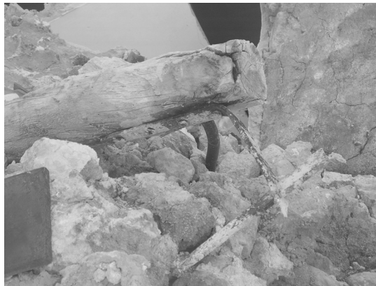
17. Castelvecchio Subequo, catene lignee ancorate con capochiavi metallici emerse dal crollo successivo al terremoto del 2009.
