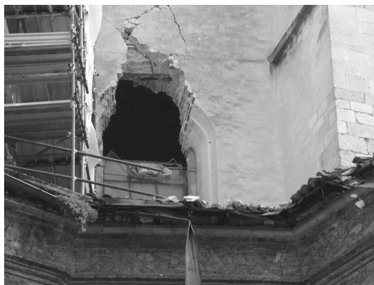
14. L'Aquila, S. Agostino, i finestroni del tiburio dopo il terremoto del 2009; in evidenza gli architravi lignei.
