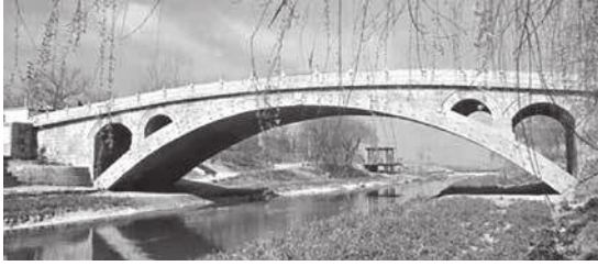
1. Ponte ad arco ribassato in pietra a Zhaoxian (VII secolo d.C.): luce 35 m, freccia 7.23 m rise ( f/l = 1/5 ), larghezza 9 m.
