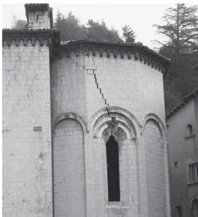
Fig. 6. a) frattura dopo il sisma; b) frattura preesistente.
