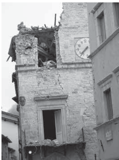
Fig. 7. a) Visso da Street View; b) danneggiamento; c) analisi al collasso del maschio.
