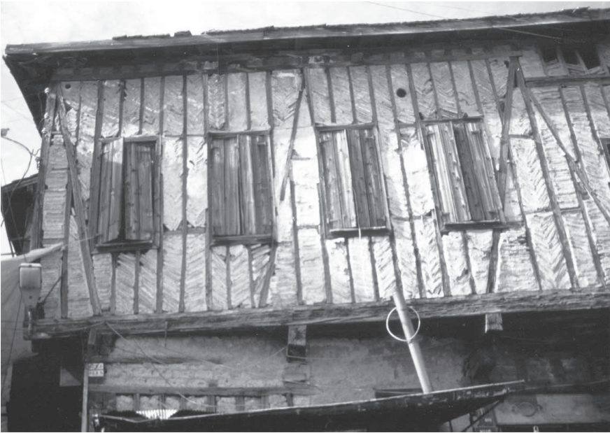
1. Ankara (Turchia), edificio con sporto ad intelaiatura lignea e riempimento in laterizio.
