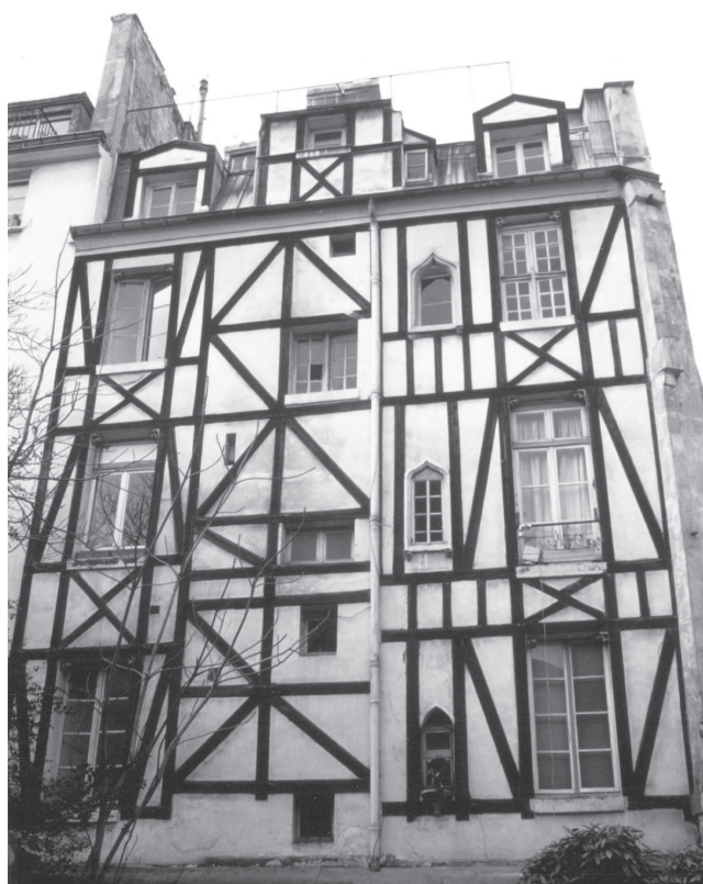
15. Casa in pans de bois a Parigi, alle spalle della chiesa di St.Julien Le Peuvre (questo edificio è stato attualmente intonacato).
