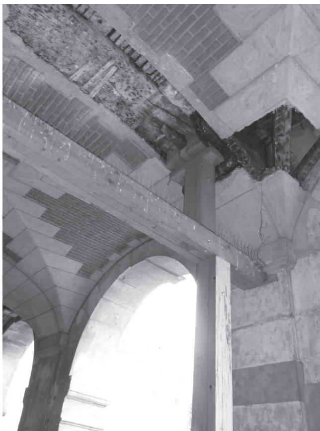
14. Place des Vosges a Parigi, alcune delle volte del portico basamentale sono realizzate con centine lignee ed incannucciata all'intradosso, il tutto è mascherato da un intonaco simulante volte in mattoni con costolonature lapidee.
