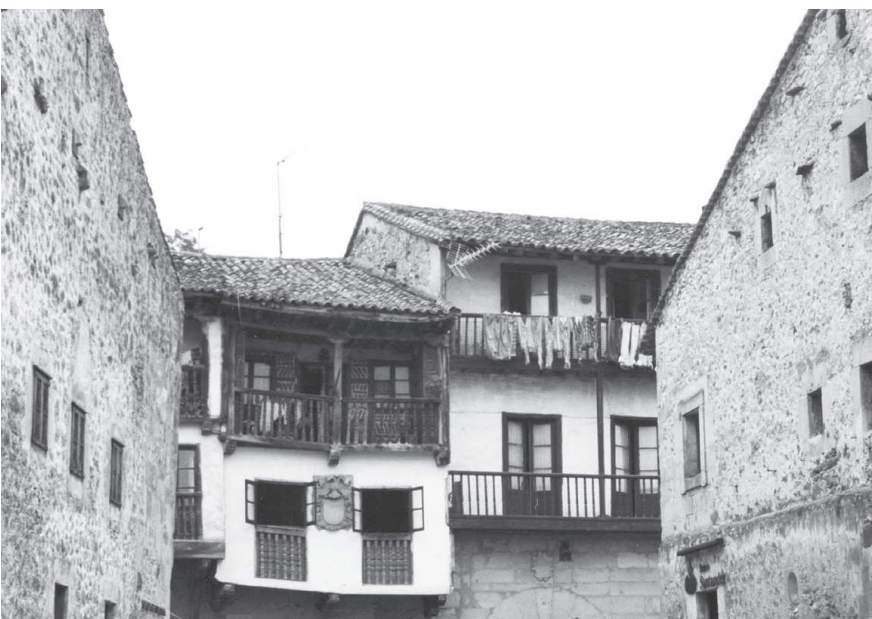
3. Santillana (Spagna) sporti in legno su edifici con basamento lapideo.
