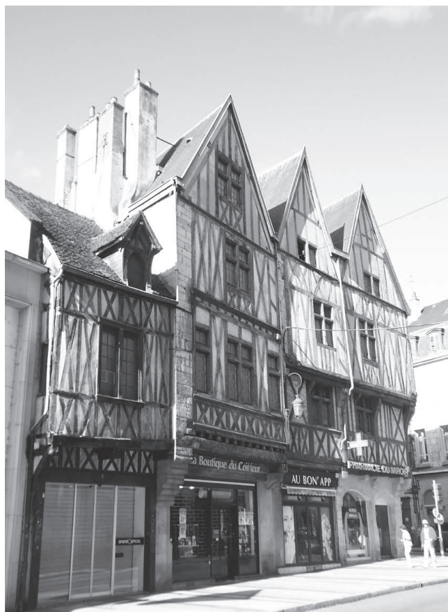
4-5. Dijon (Francia), una strada del centro storico caratterizzata dalla presenza di edifici in pans de bois ; dettaglio costruttivo di un edificio medievale nel quale si osserva la raffinatezza degli intagli e del trattamento laterizio del riempimento.
