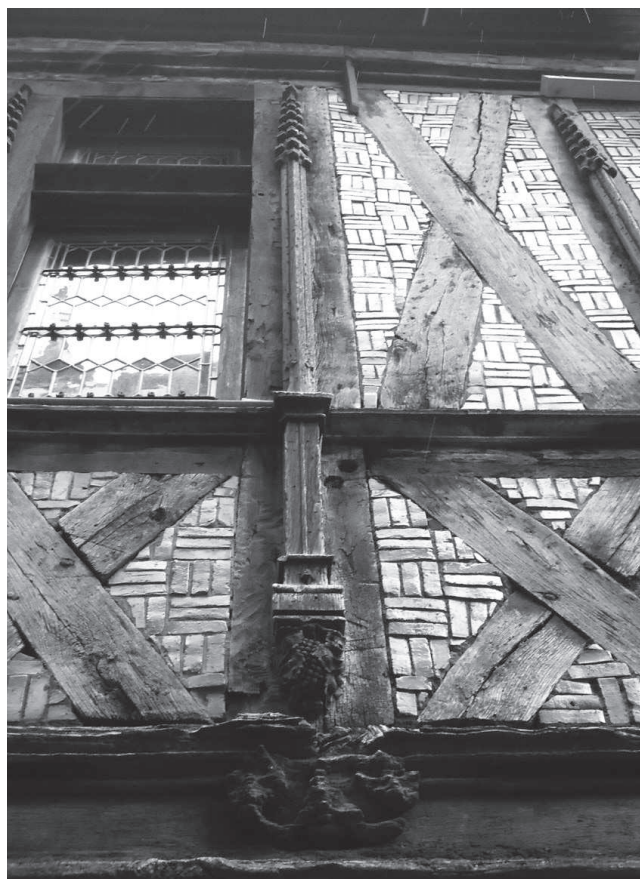
4-5. Dijon (Francia), una strada del centro storico caratterizzata dalla presenza di edifici in pans de bois ; dettaglio costruttivo di un edificio medievale nel quale si osserva la raffinatezza degli intagli e del trattamento laterizio del riempimento.
