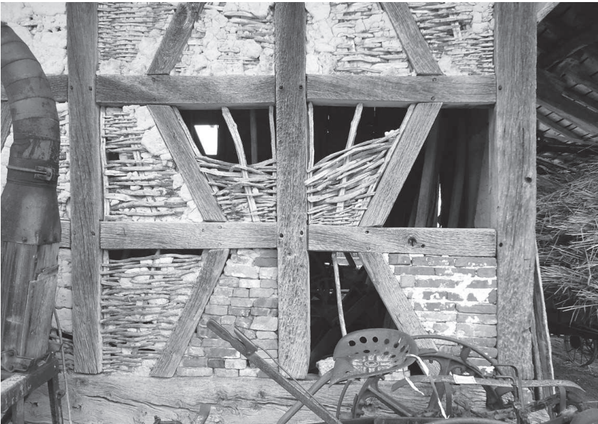
9. Dettaglio dell'originario riempimento a graticcio ( torchis ) e tamponamenti recenti in mattoni, nella ferme de la Forêt a Courtes, Ain (Francia).
