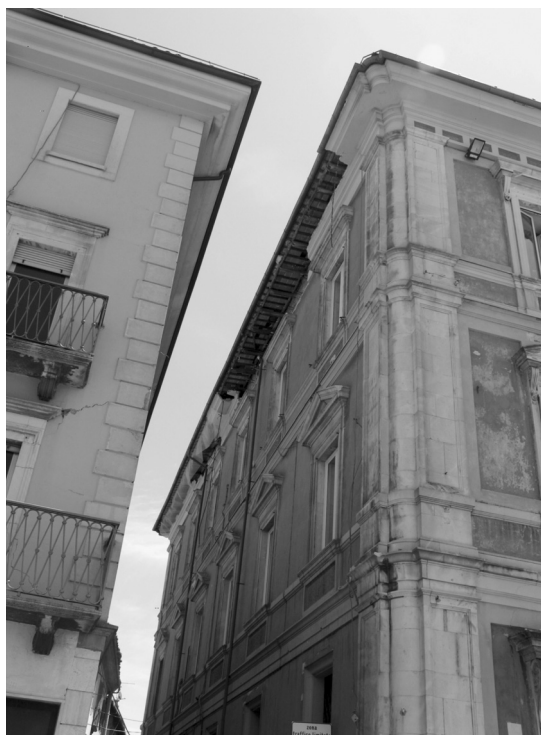
26. Palazzo patrizio di fronte alla Cattedrale con fermagli semplici collocati nella costruzione successiva al terremoto del 1703, in buone condizioni tranne la cornice, realizzata con un guscio di stucco su armatura lignea applicata ai palombelli del tetto, anziché costruita con muratura di mattoni a sbalzo. I palombelli hanno vibrato, provocando il crollo della cornice. A sin., casa borghese coeva, priva di tiranti e quindi percorsa da pericolose crepe diagonali sul fronte.
