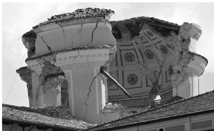
20. Si notano le tre legature sovrapposte in legno, slegate dopo l'ultimo terremoto. Una ricostruzione in analogia con la struttura precedente sarebbe possibile, riproducendo la cupola con mattoni e stucco previo un consolidamento del tamburo eseguito con buoni materiali murari. Sarebbe tuttavia più prudente utilizzare una struttura di legno lamellare coperto di cannuce e stucchi debitamente legato ad un ombrello (un ragno), anch'esso di legno lamellare.
