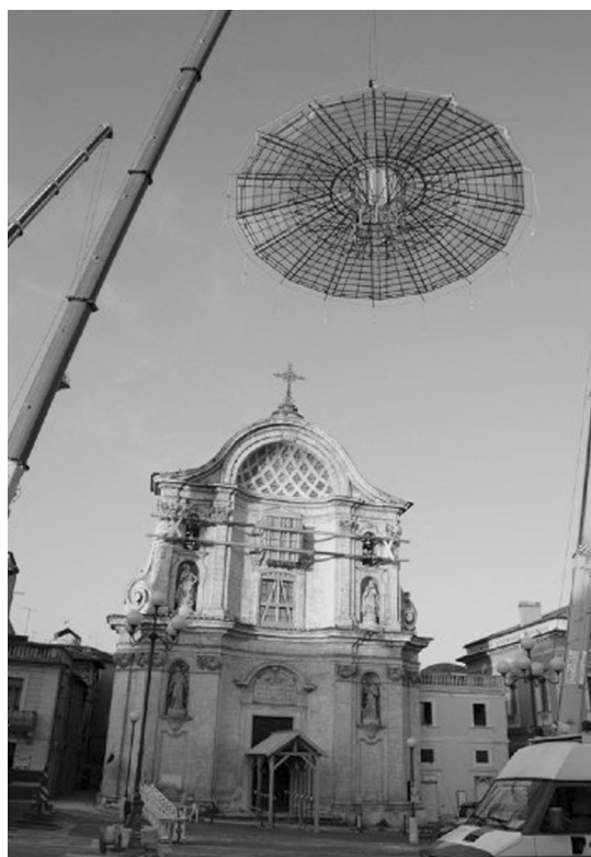
23. La Chiesa delle Anime Sante mentre si sta montando una struttura ad ombrello interna in tubi di acciaio e pistoni oleodinamici predisposta per l'alloggiamento della futura copertura e per la realizzazione delle opere di restauro e consolidamento. Ci si augura che i Francesi, candidatisi per il restauro, realizzino un tetto ed una cupola in legno alla maniera di Philibert de l'Orme, onde rendere la copertura il più possibile leggera ed elastica (nonché ecosostenibile).
