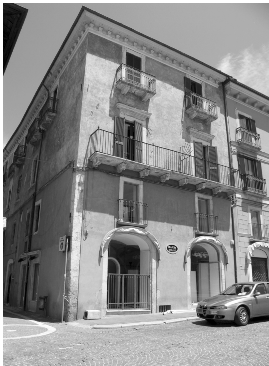
24. L'Aquila. Una casa borghese sulla Piazza della Cattedrale, munita di fermagli metallici applicati a tiranti in legno (di tipo 'borbonico', vedi oltre) in fase di costruzione e di incremento di un piano d'altezza, ben conservata nelle strutture principali.
