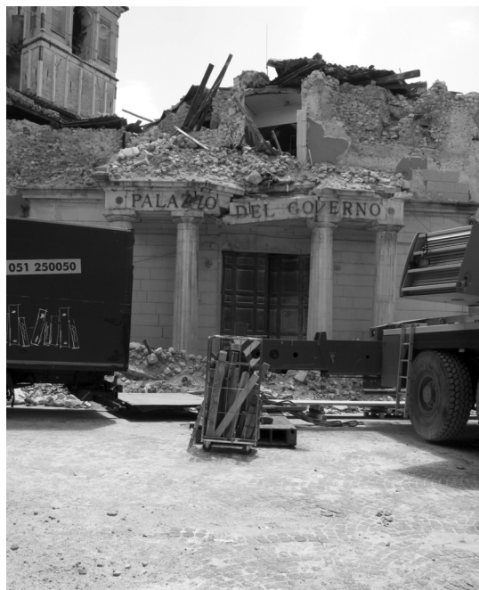
33. A pochi passi dal Palazzetto delle figure precedenti il Palazzo del Governo, evidentemente costruito assai male ed infatti sbriciolato, databile al XIX secolo per l'ostentazione di lineamenti grecizzanti.
