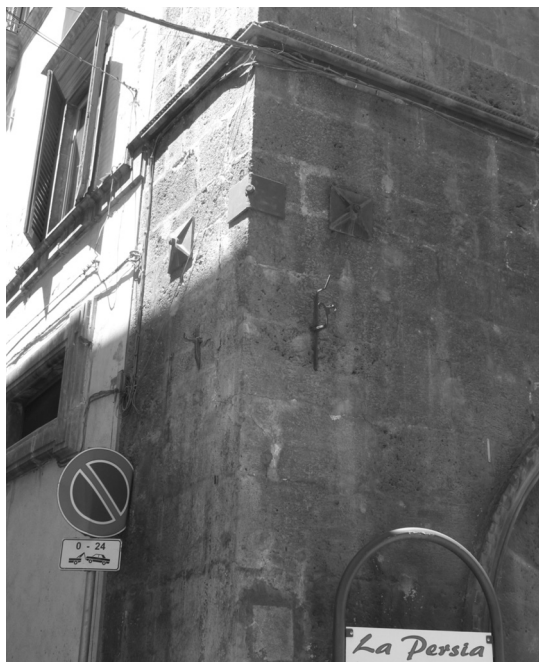
32. Il palazzetto patrizio delle figg. 30) e 31). Si notano i fermagli semplici (ad I) della struttura anteriore, ed i fermagli a piastra di un consolidamento relativamente moderno al livello del solaio, con un tirante diagonale.
