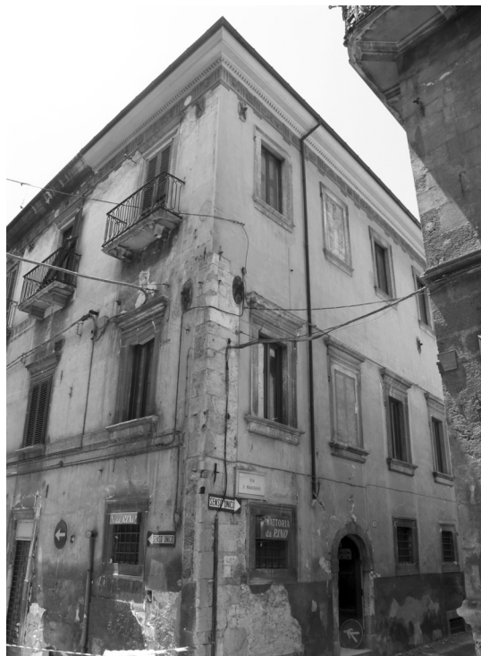
25. Altra casa borghese presso la Piazza della Cattedrale, con ben visibili i fermagli semplici applicati ai tiranti in legno di tipo 'borbonico' della pristina elevazione a due piani fuori terra, e dell'aumento di altezza di un piano, con fermagli a piastra.
