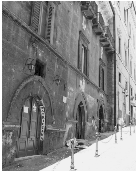
31. Il palazzetto patrizio della fig. 30, con evidente la struttura in conci di pietra squadrata del Piano terreno e del Piano nobile. Si scorge qualche fermaglio semplice (ad I) dei tiranti in legno.
