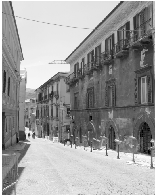
30. L'Aquila. Palazzetto patrizio vicino alla Cattedrale, risalente al sec. XV nelle strutture in pietra a conci squadrati del piano terreno, al sec. XVII nelle strutture in pietra del Piano nobile e del relativo ammezzato, al sec. XVIII nelle strutture dell'ultimo piano e del tetto. Le strutture principali sono in buone condizioni, anche grazie ad un interrimento parziale.
