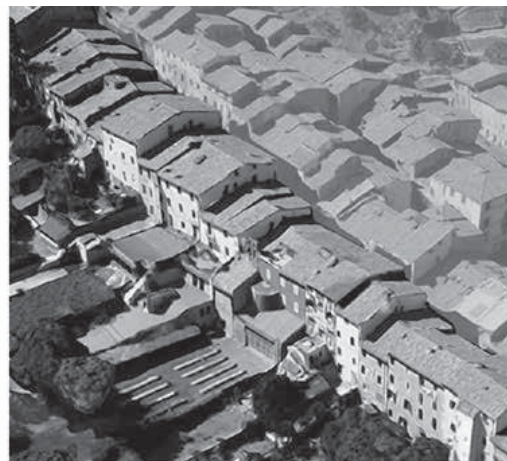
11. Siena: schema tipologico e immagine della Contrada del Bruco, con gli edifici scalati secondo il pendio naturale, concepiti in modo da formare un unico organismo strutturale dove ciascuna cellula tende a sostenere quelle sovrastanti.
