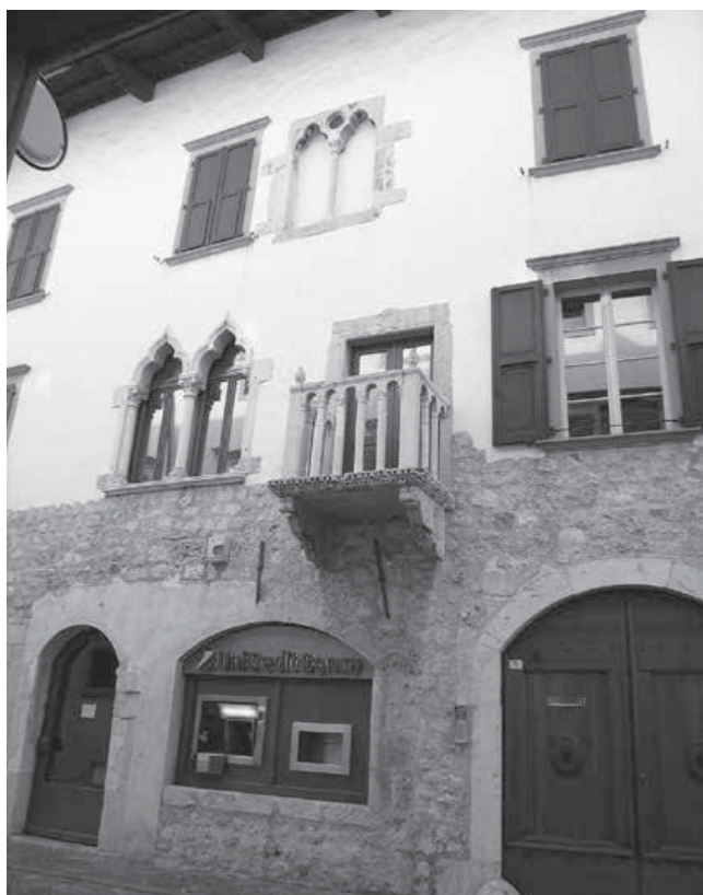
20. Fronti di edifici del centro storico di Venzone, ricostruiti conservando le murature superstiti e ricomponendo gli elementi architettonici in pietra recuperati dal crollo.
