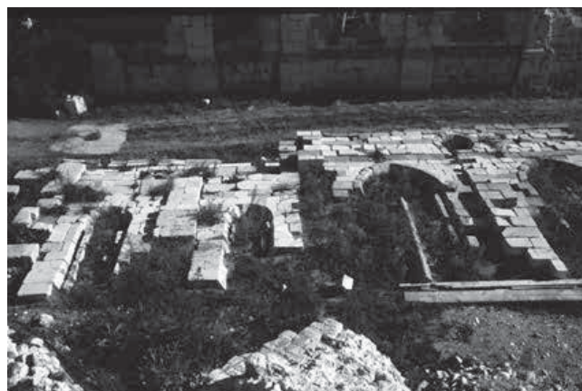
17. Vista delle pietre recuperate e ricomposte a terra a ricostituire i fronti della Sagrestia e della Cappella del Gonfalone (1984).
