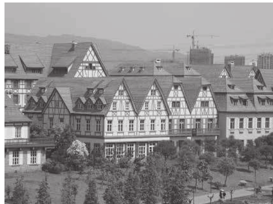
4. Colmar. Case in calcestruzzo armato imitanti strutture in Fachbau.
