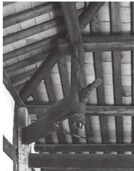
7. Wufeng. Strutture originarie conservate sotto il nuovo tetto nel tempio Guangdong.
