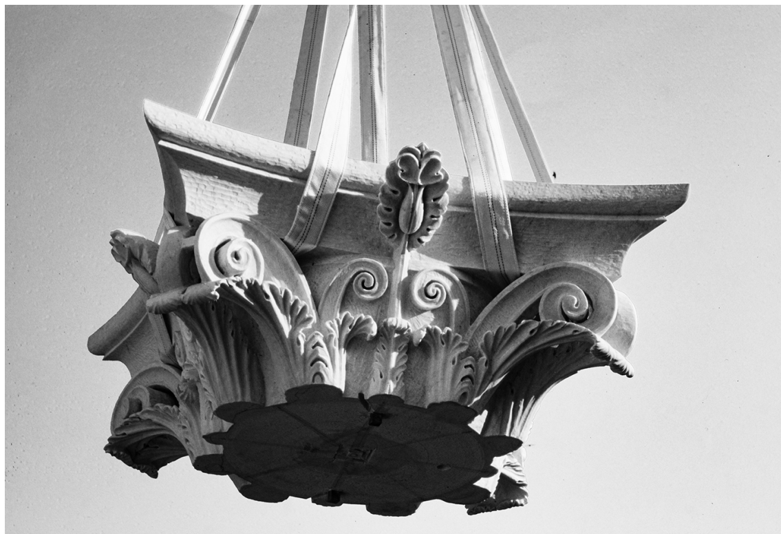
1. Montaggio di un semicapitello in marmo di Carrara d'integrazione, scultore Ettore Mariani (Pietrasanta, Lucca), fase del restauro del Tempio di Ercole al Foro Boario, Roma, 1997 (foto Z. Colantoni).
