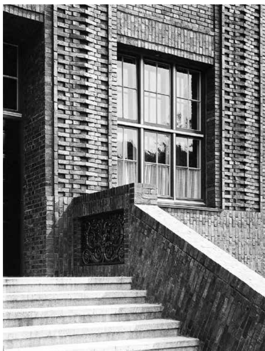
2. Dettaglio della scala di accesso principale (1926) con la balaustra neoclassica della casa della nonna paterna inserita nella muratura. Si notino anche le lesene ottenute mediante la rotazione dei mattoni in Klinker . Foto: Fratelli Dransfeld. Amburgo, Archivio del Warburg-Haus.
