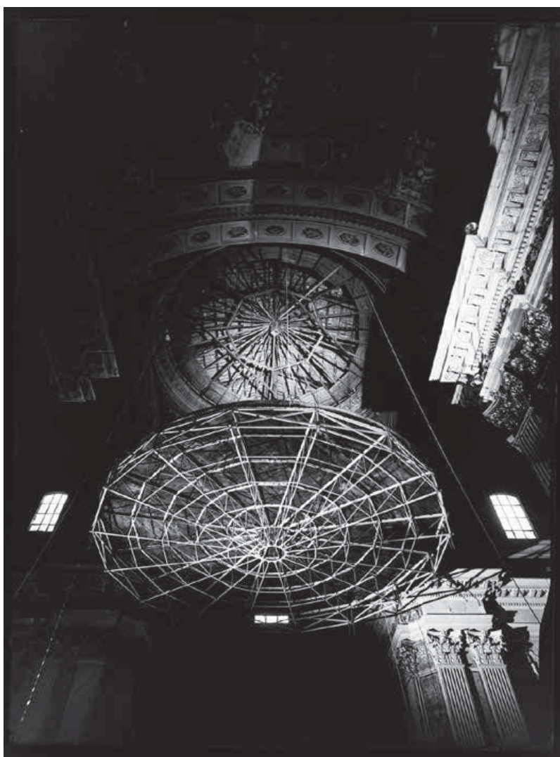
5. Il 15 maggio del 1962 la tela di A. Pozzo viene portata a terra per essere restaurata con l'ausilio del nuovo telaio a tralicci metallici. Per gentile concessione dell'Archivio Fotografico del Polo Museale del Lazio, Fondo Hermanin, L. 442.
